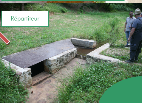
Déversoir et évacuation des eaux de fond
